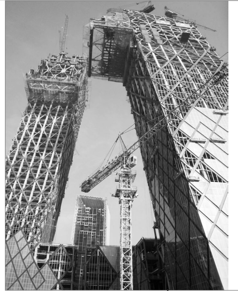
내민 부분들이 서로 연결될 때까지 공사하여 중앙부에서 만나게 한 내민 부분 시공시에는 온도와 바람의 영향까지도 세심하게 고려하여야 했다.
